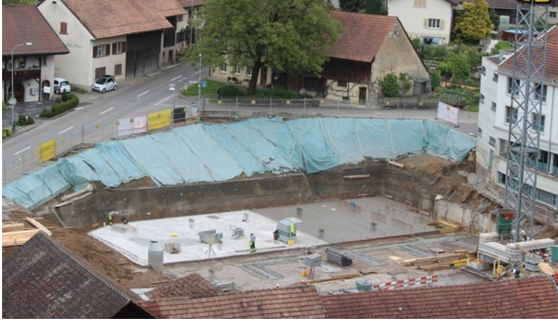
Auffällig: Die grosse Baugrube direkt neben der Endingerstrasse in Würenlingen. Quelle: Nadja Rohner
